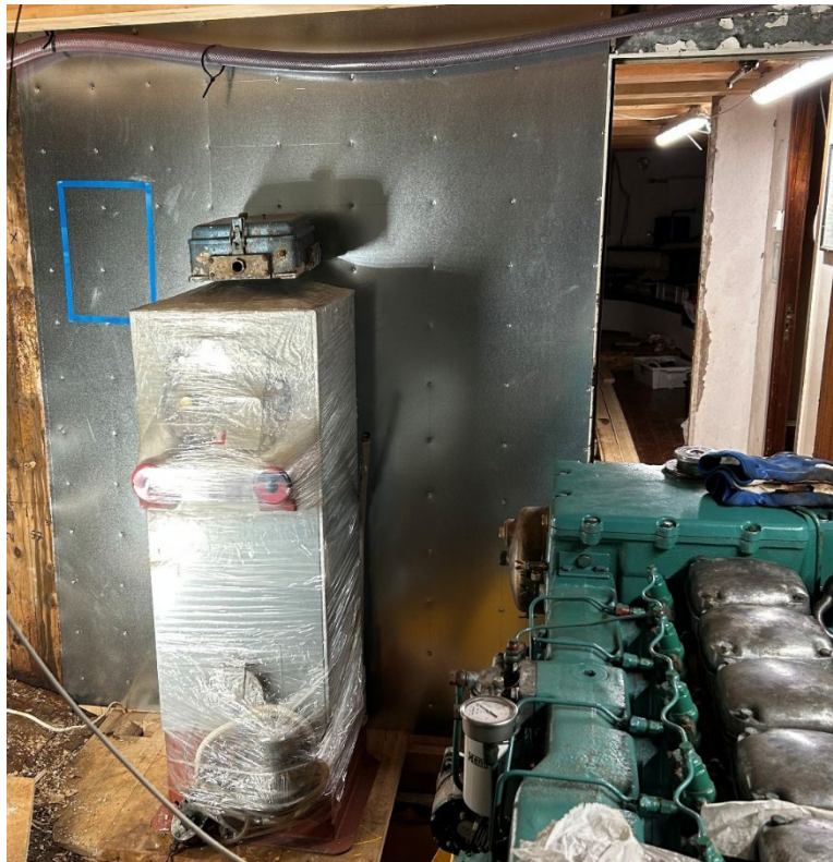
Klart for montering av landstrømstilkobling
